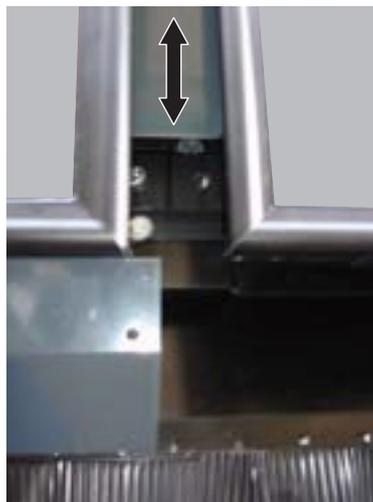
5. Insérer les écrous à billes dans les rainures des capteurs solaires suivant les cotes ci-après.
